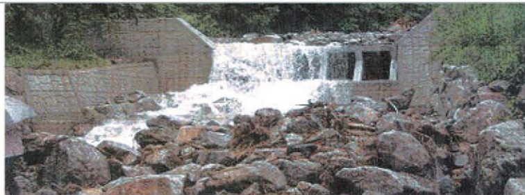
지난해 설치된 강원 인제군 인제읍 원대리 계곡의 사방댐에 18일 폭우가 그친 뒤 급류에 휩쓸려온 폐목과 토사, 돌 등이 가득 쌓여 있다(오른쪽 사진). 사방댐은 물길의 속도를 늦추는 동시에 돌이나 폐목 등을 걸러주기 때문에 피해를 방지하는 효과가 있다. 왼쪽 사진은 장마 전 원대리 계곡 사방댐의 모습. 사진 자료 제공:인제군청
