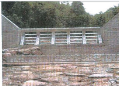
지난해 설치된 강원 인제군 인제읍 원대리 계곡의 사방댐에 18일 폭우가 그친 뒤 급류에 휩쓸려온 폐목과 토사, 돌 등이 가득 쌓여 있다(오른쪽 사진). 사방댐은 물길의 속도를 늦추는 동시에 돌이나 폐목 등을 걸러주기 때문에 피해를 방지하는 효과가 있다. 왼쪽 사진은 장마 전 원대리 계곡 사방댐의 모습. 사진 자료 제공:인제군청
