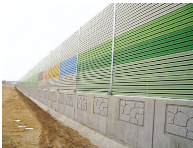
평택~시흥간 고속도로 1공구
