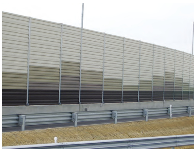
평택~시흥간 고속도로 1공구
