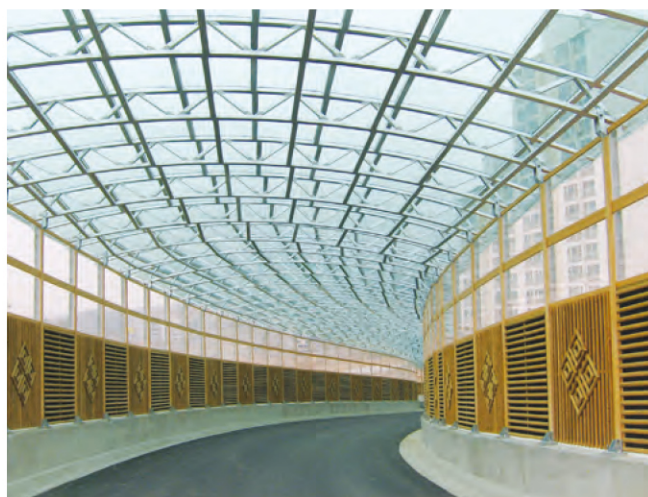
용인구성 향린동산 방음터널
