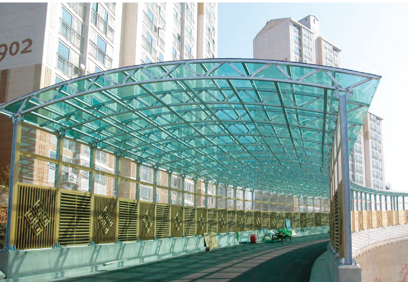
용인구성 향린동산 방음터널
