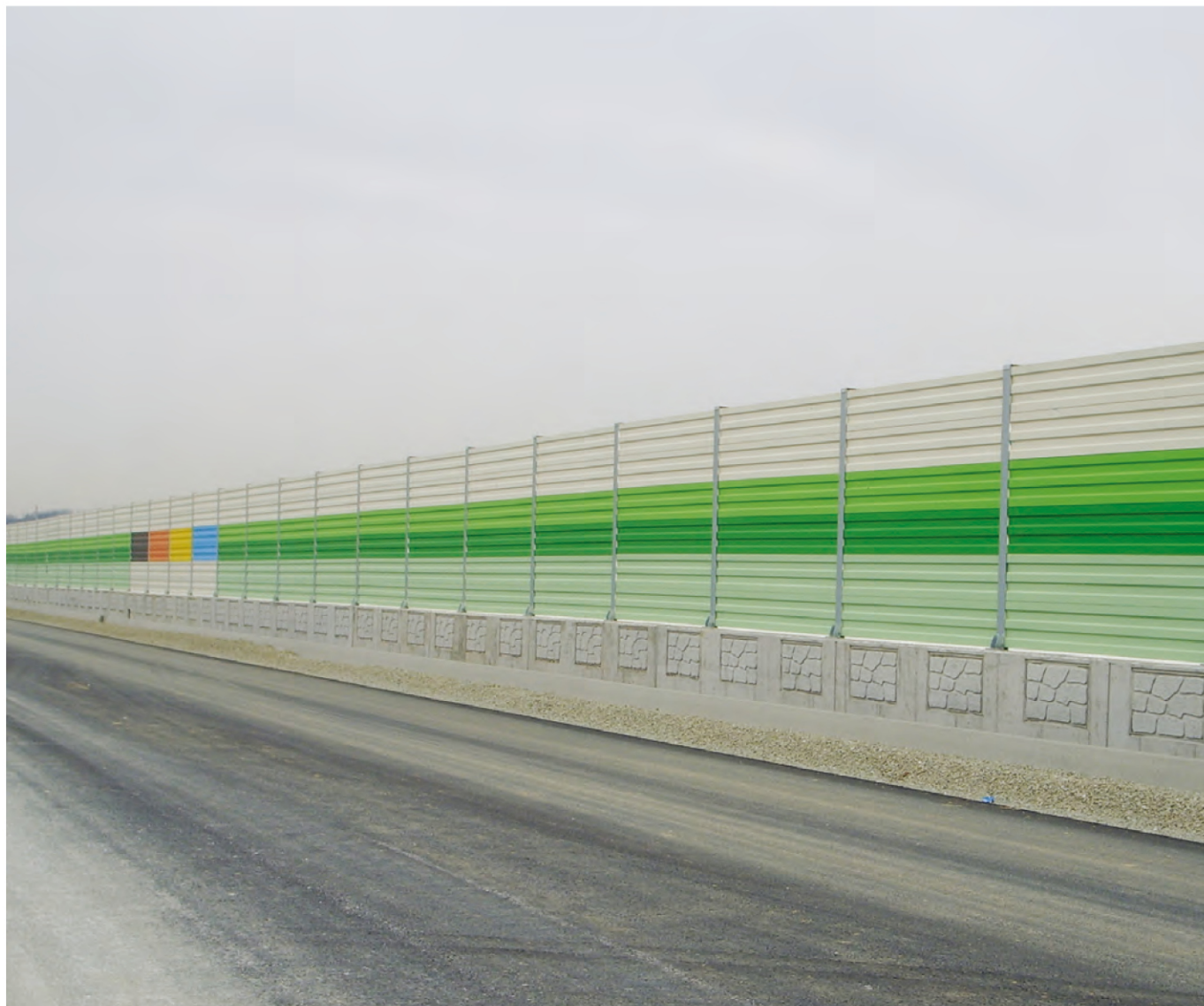
평택~시흥간 고속도로 1공구
