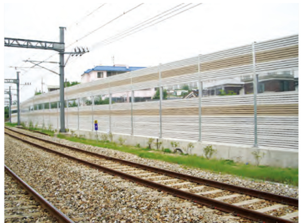
호남선철도 조차장~서대전 구간
