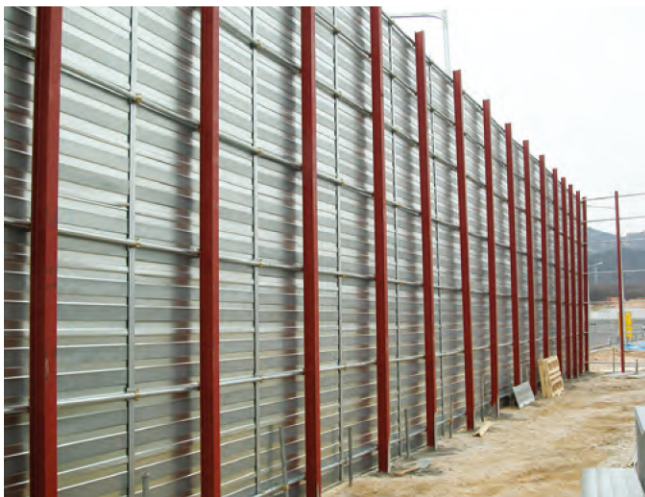
남양주 별내지구 1공구
