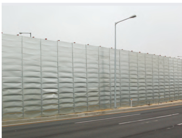
남양주 별내지구 1공구
