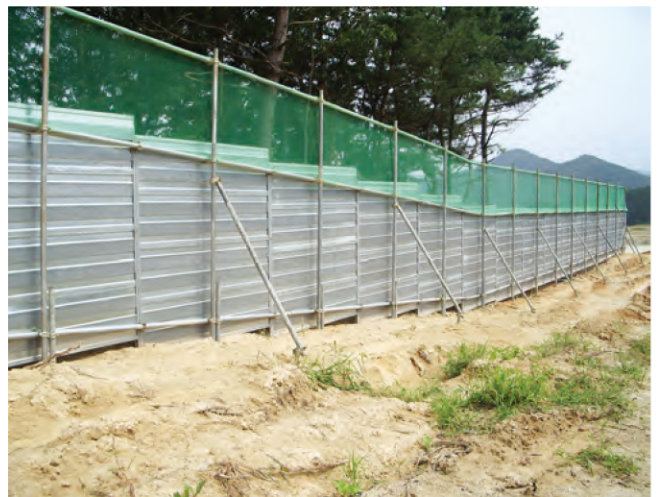
계백로 우회도로 1공구
