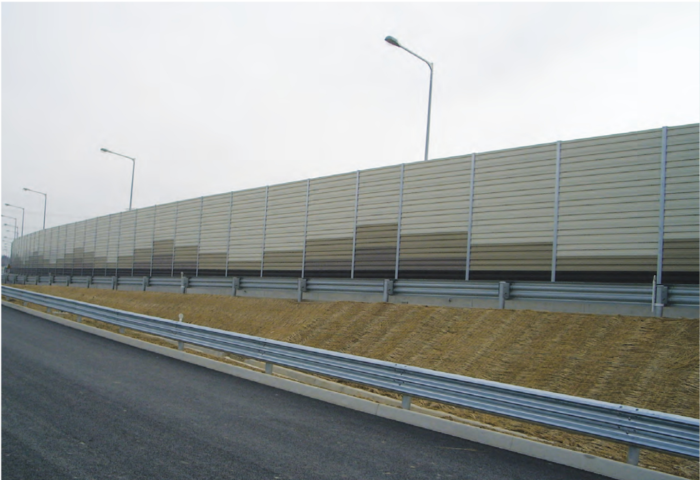
평택~시흥간 고속도로 1공구
