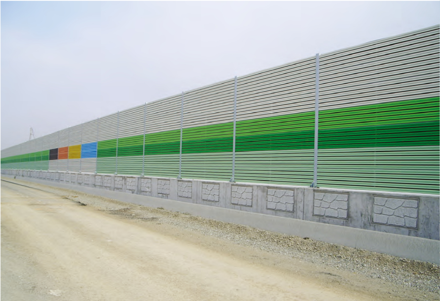
평택~시흥간 고속도로 1공구
