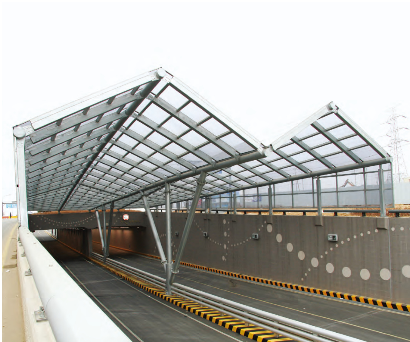
파주 운정2단계 택지개발공사~지하도케노피
